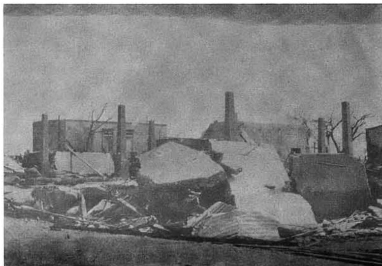
Estación de gasolina destruida. / Gasoline Service Station destroyed.
