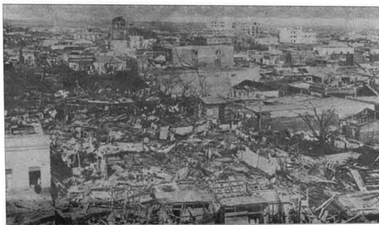
Vista parcial de la ciudad en la que se puede apreciar los efectos producidos por el violento meteoro. / Partial view of the city in which can be appreciated the effects produced by terrible hurricane.
