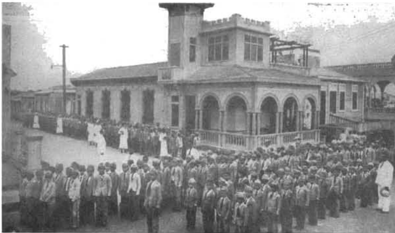
Las modernas y bellas edificaciones que se admiran en la presente gráfica, corresponden al gran número de construcciones efectuadas en el barrio de San Carlos, después del ciclón de 1930. En primer término, el alumnado de la Escuela Graduada "Chile" en dos alas y en correcta formación.
