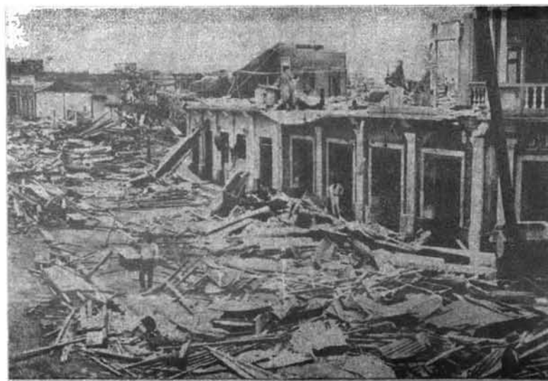
La Avenida "Duarte" esquina "Mella", completamente destruida por el huracán.
