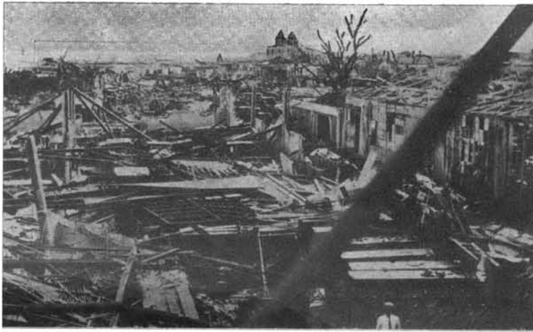
LA CALLE 12 DE JULIO (GAZCUE) DESPUES DEL HURACAN.-La calle 12 de Julio (Gazcue) después de recibir los furiosos embates del huracán quedó convertida en un hacinamiento de escombros.
