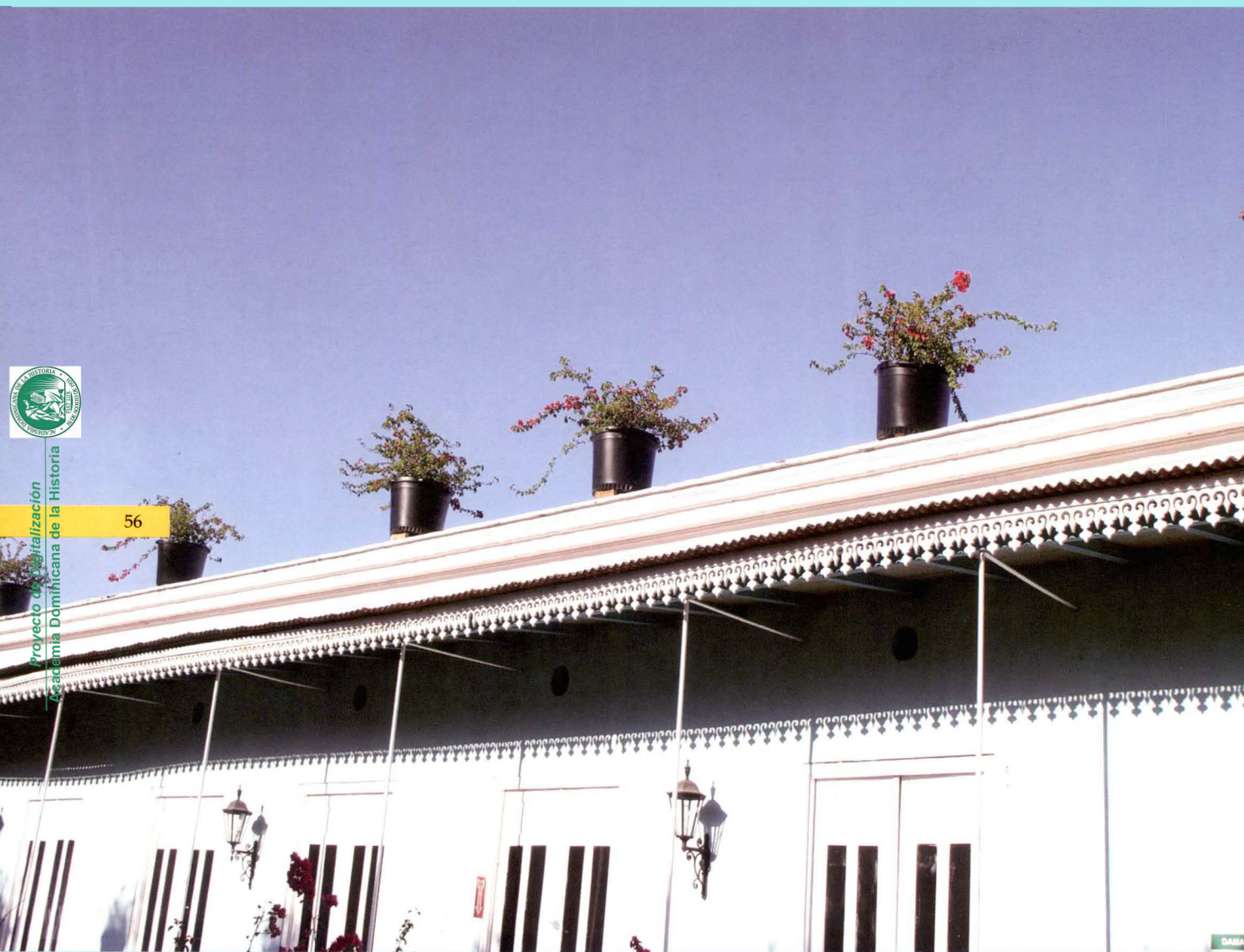
Vista del techo del edificio.
