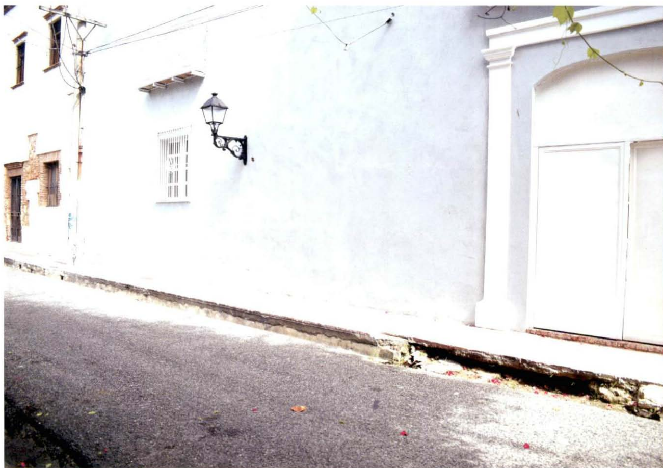
Como luce la fachada posterior, después de los trabajos de remozamiento.
