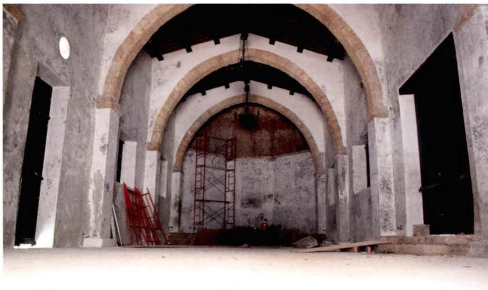
La Capilla de la Soledad mientras estaba en proceso de restauración y adecuación para convertirse en el salón de actos de la Academia Dominicana de la Historia.
