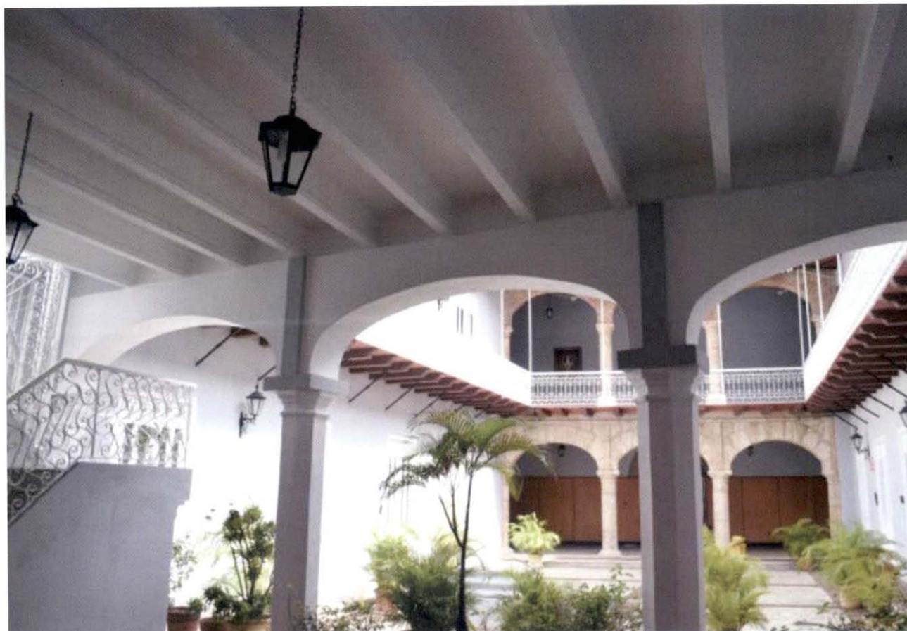
... luego de los trabajos, lucen de esta manera.
