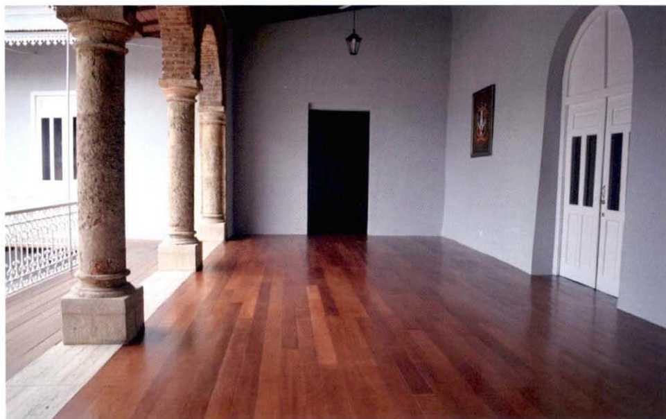
Vista desde la escalera que da acceso al segundo nivel del piso de madera y balcón de la Casa de las Academias.
