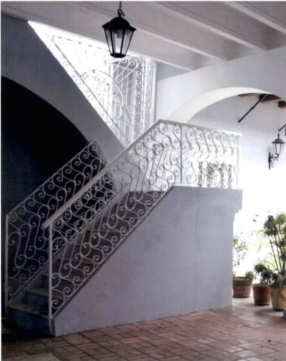
La escalera, el piso y el techo de esta área ahora lucen de esta forma.
