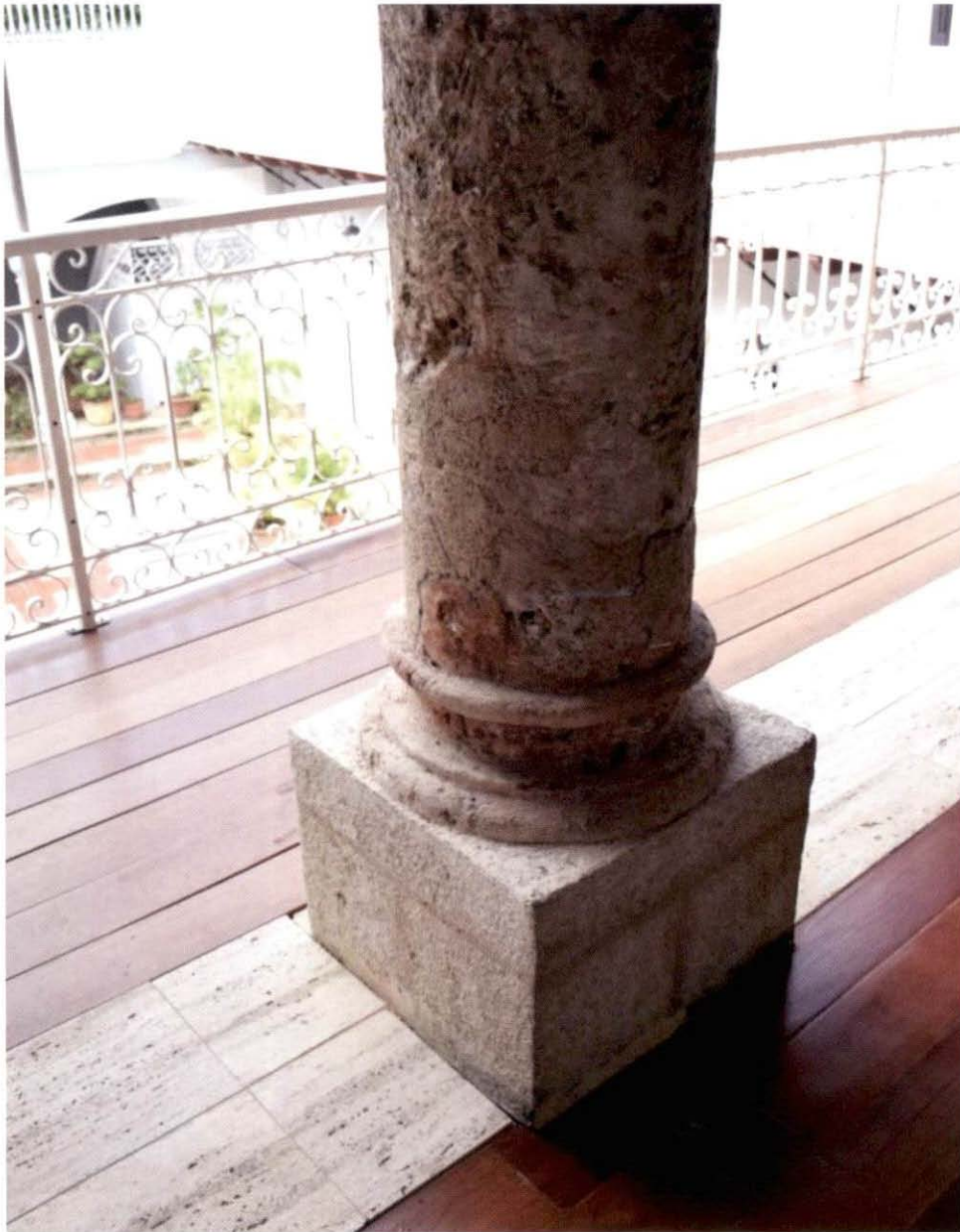
Los pisos fueron removidos y se colocaron nuevas tablas de maderas.
