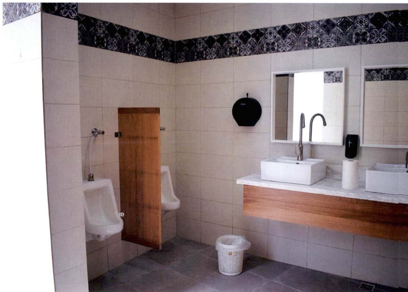
Todos los utensilios de los baños fueron cambiados: urinarios, sanitarios, lavamanos, espejos, dispensadores de jabón, entre otros.
