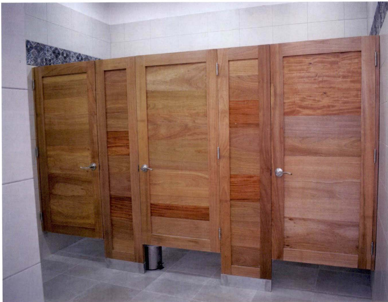
Luego de la renovación, lucen de esta manera.
