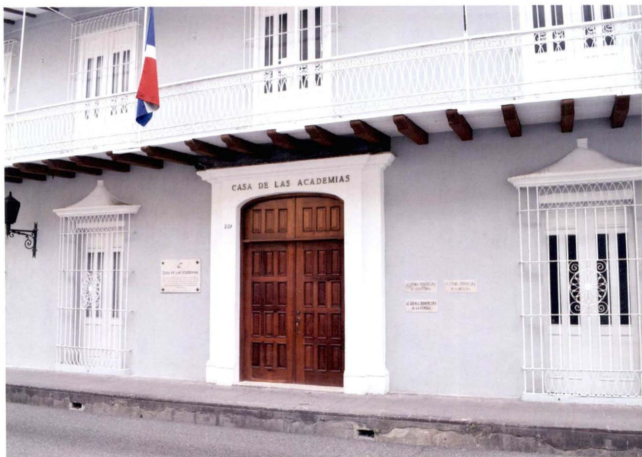
Fachada y puerta restauradas de la Casa de las Academias.
