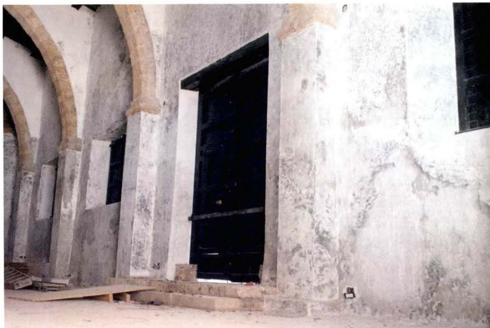
Puerta de entrada, columnas y paredes, vista desde adentro de la Capilla de la Soledad, cuando se encontraba en proceso de remozamiento.
