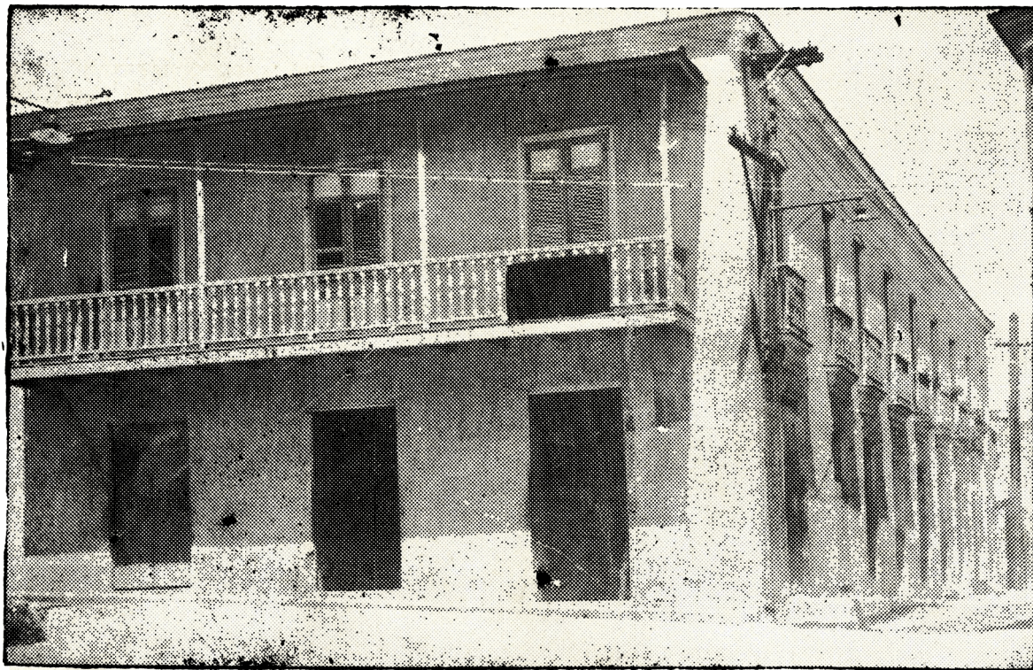
Casa que incluye la que ocupó el almacén de D. Juan José Duarte y Rodríguez hacia 1837-1845 : corresponde a la núm. 1 de la calle Vicente Celestino Duarte
