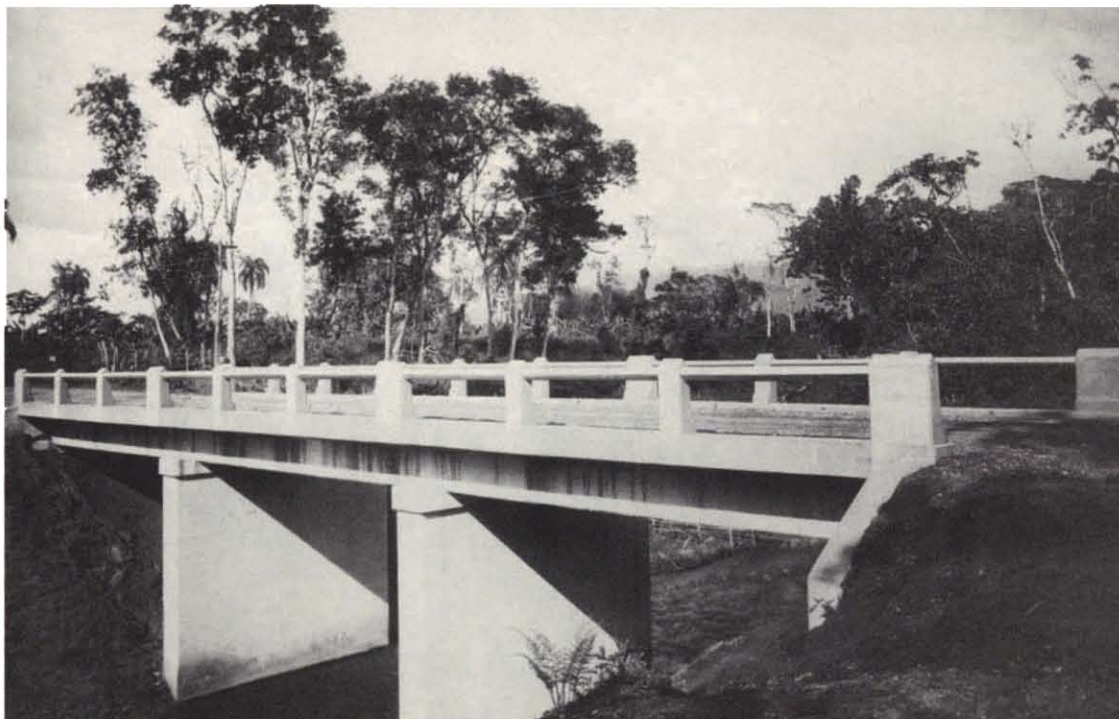
Puente Arroyo Ingenio, carretera Duarte.
